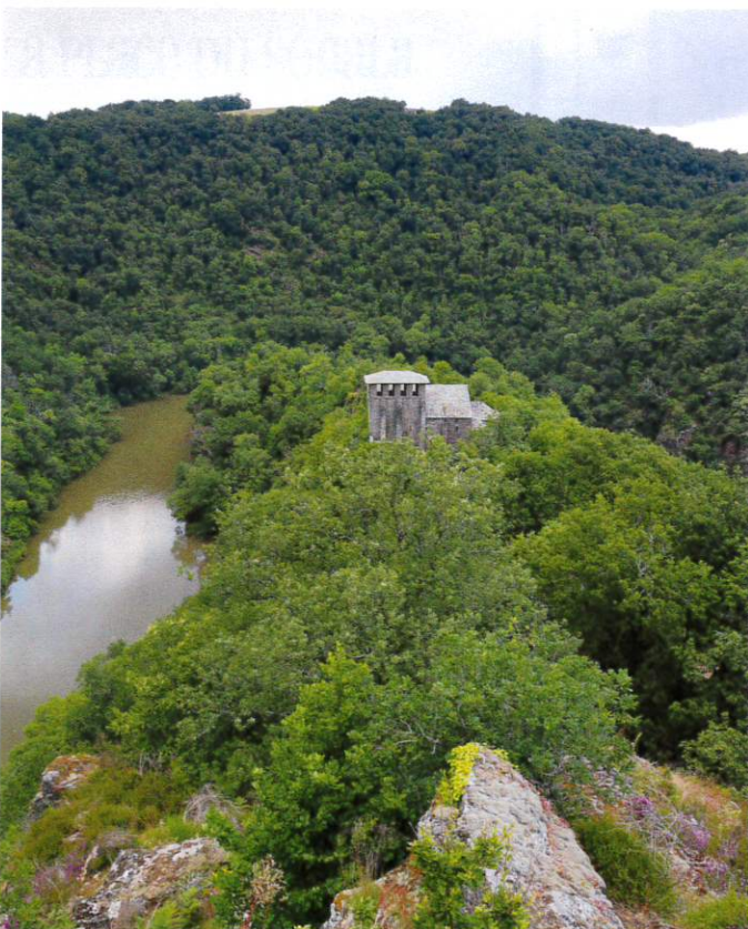
Ci-dessus : La chapelle des Planques À droite : Le viaduc du Viaur - photos : Jérôme Morel
